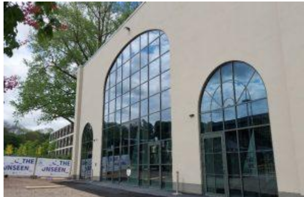
Eingang der Kulturhauptstadtzentrale
